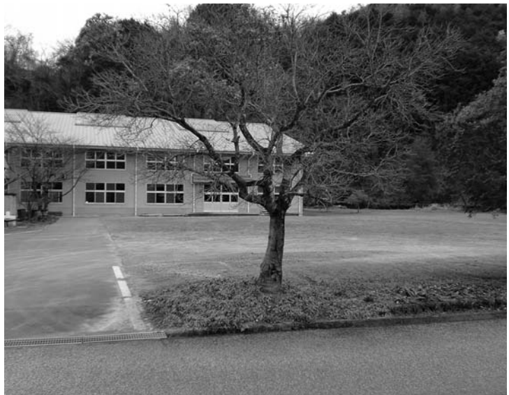
未舗装が多く残る町民会館駐車場
