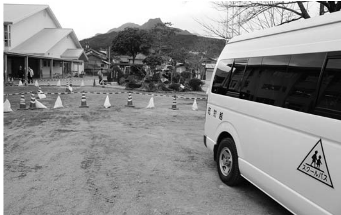
舗装が始まった小学校校庭
