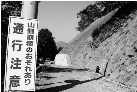
復旧が進む山室線
