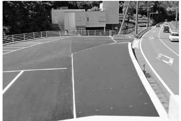
高吾苑側に完成した駐車場
