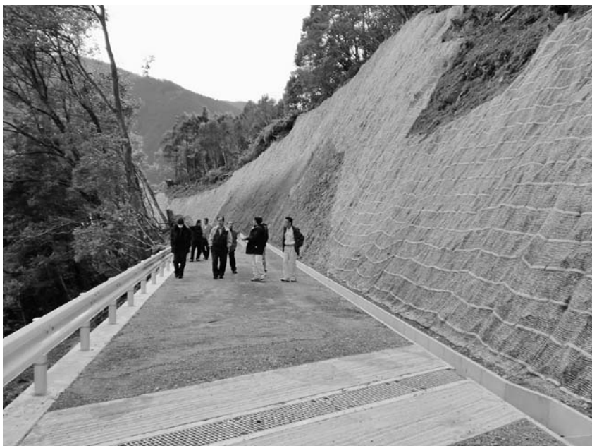
林道工事で山を生かす
