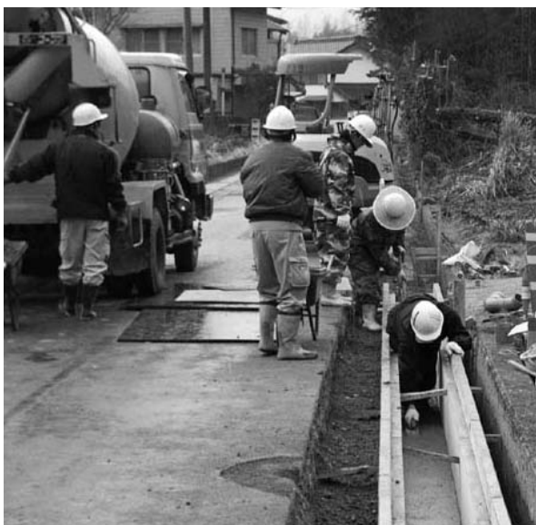
側溝工事で道がきれいになる
