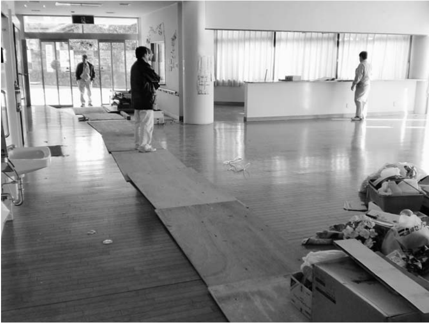
改修工事が始まったコスモス荘
