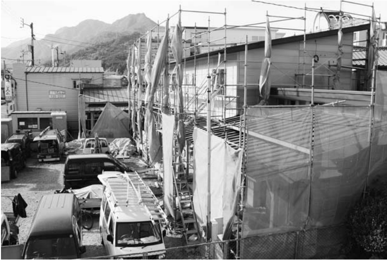
完成目指して急ピッチ
