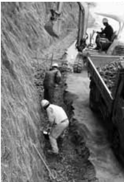
改良工事が進む山室線
