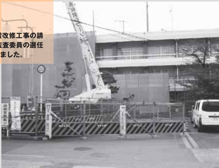
耐震工事で安全な庁舎に
